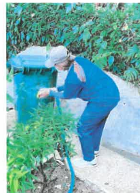
ภาพถ่ายที่ 2.2-1 ตำแหน่งระบบบำบัดน้ำเสียของแต่ละอาคาร การเดิมหัวเชื้อชีวภาพในถังบำบัด
