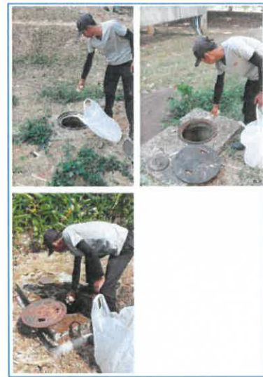
ภาพถ่ายที่ 2.2-1 ตำแหน่งระบบบำบัดน้ำเสียของแต่ละอาคาร การเดิมหัวเชื้อชีวภาพในถังบำบัด
