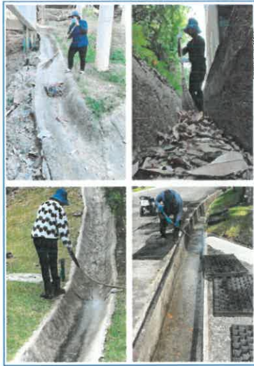
ภาพถ่ายที่ 2.2-5 การทำความสะอาดรางระบายน้ำ
