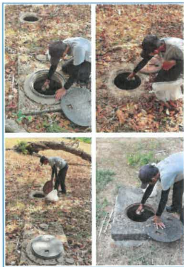
ภาพถ่ายที่ 2.2-1 ตำแหน่งระบบบำบัดน้ำเสียของแต่ละอาคาร การเดิมหัวเชื้อชีวภาพในถังบำบัด
