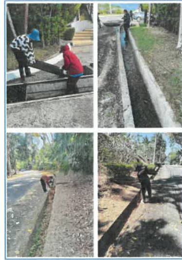
ภาพถ่ายที่ 2.2-5 การทำความสะอาดรางระบายน้ำ
